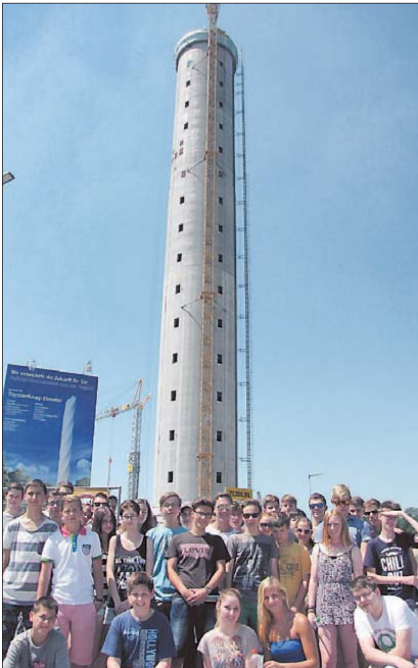
Schüler des Gymnasiums Trossingen besuchten die Turmbaustelle in Rottweil.
